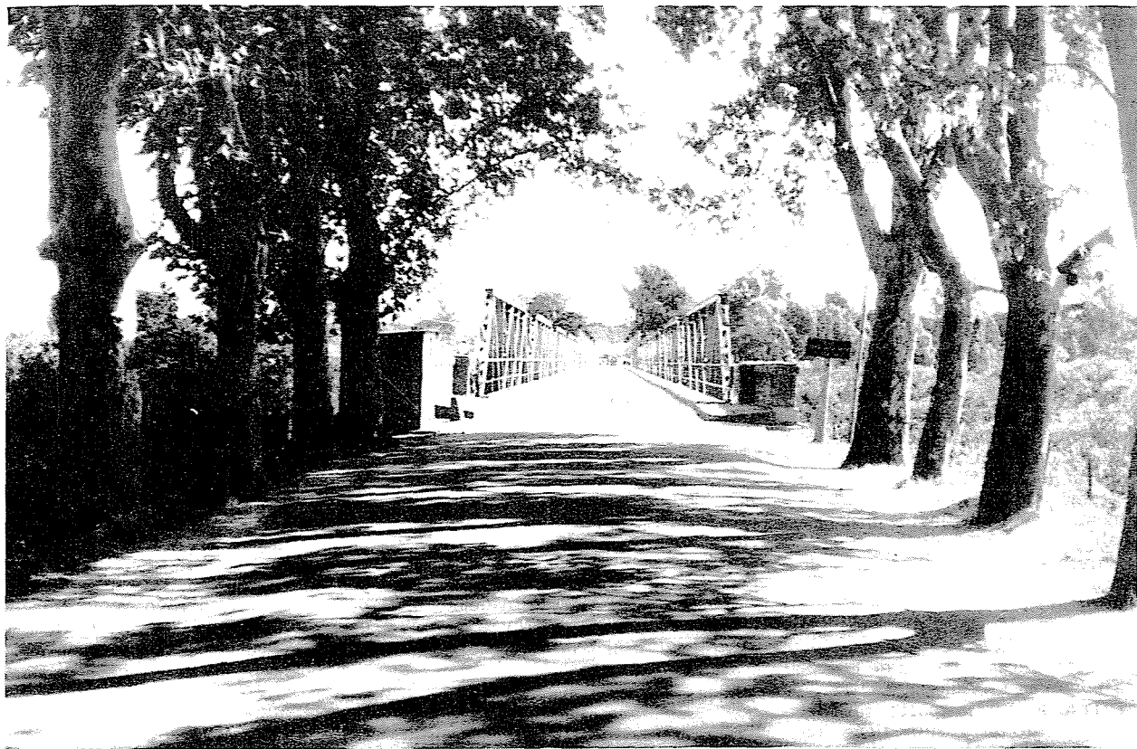
El puente de acceso a la ciudad.
