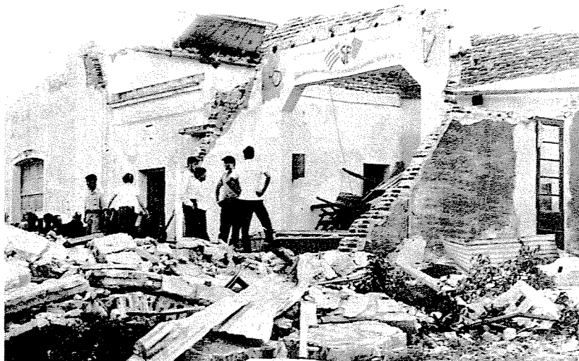
Los destrozos del tornado que azotó a Fray Marcos. La ayuda y el trabajo aún no se han organizado adecuadamente.
