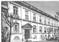
13. Fachada sobre Cuareim
