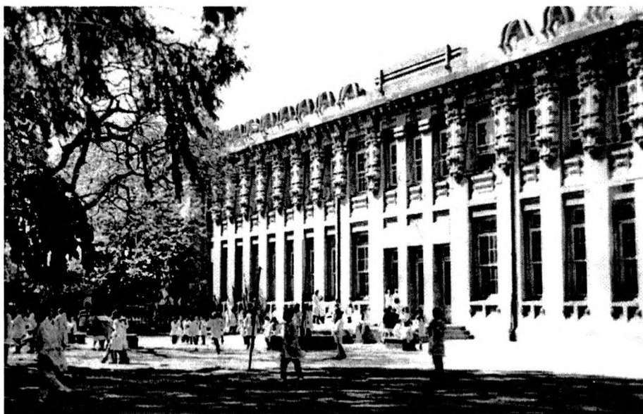
36. Fachada sobre el patio (1997)
