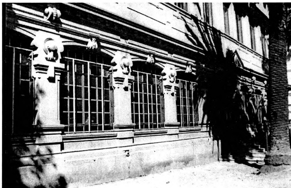
56. Detalle de la fachada principal (1997).
