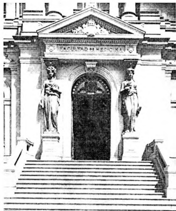
Fig. 18 - Detalle de la entrada principal del edificio de la Facultad de Medicina, enmarcada con alegorías a la ciencia y coronada por frontón, todo construido en granito.
