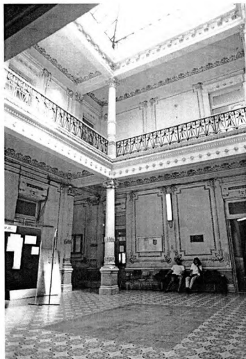
Fig. 32 - Vestíbulo a doble altura. La yesería, herrería y el pavimento incluyendo ladrillo de vidrio, definen su carácter.
