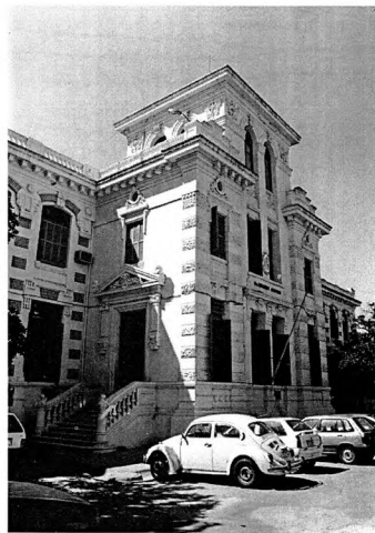
Fig. 31 - Escalera lateral de acceso, vista actual.
