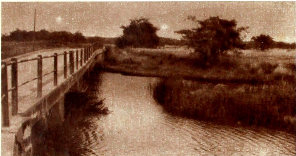
Puente sobre el Paso del Potrero con el Santa Lucía en su curso superior (Lavalleja).
