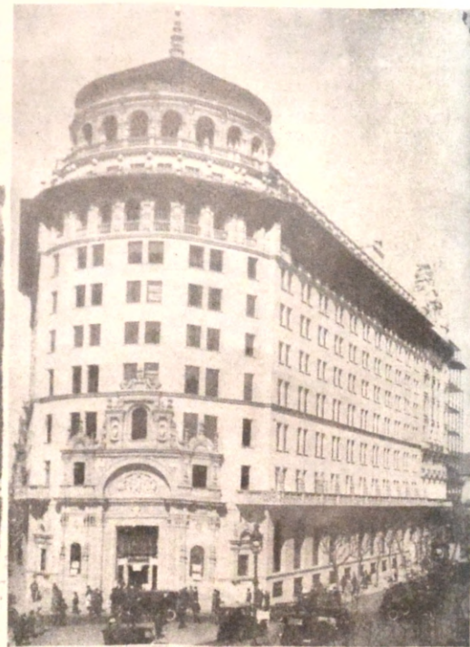
Frente del nuevo edificio del Banco de Boston en Buenos Aires que fué inaugurado la semana pasada
