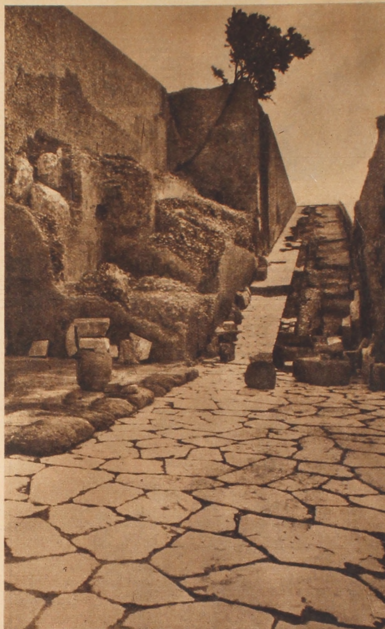
Una de las rampas ascendentes. La parte enlosada (es original) quedaba al descubierto fuera del porticado que cubría el resto de la superficie de la rampa. (Fot. Gullini).
