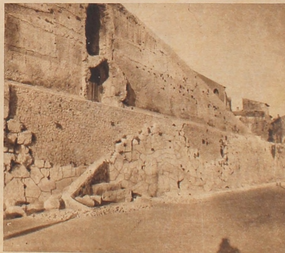
El muro con los dos grandes nichos y una de las rampas que en él se apoyan. (Fot. del autor).
