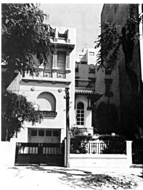
Fig.10 - Residencia ubicada en Tomás Diago 765.
