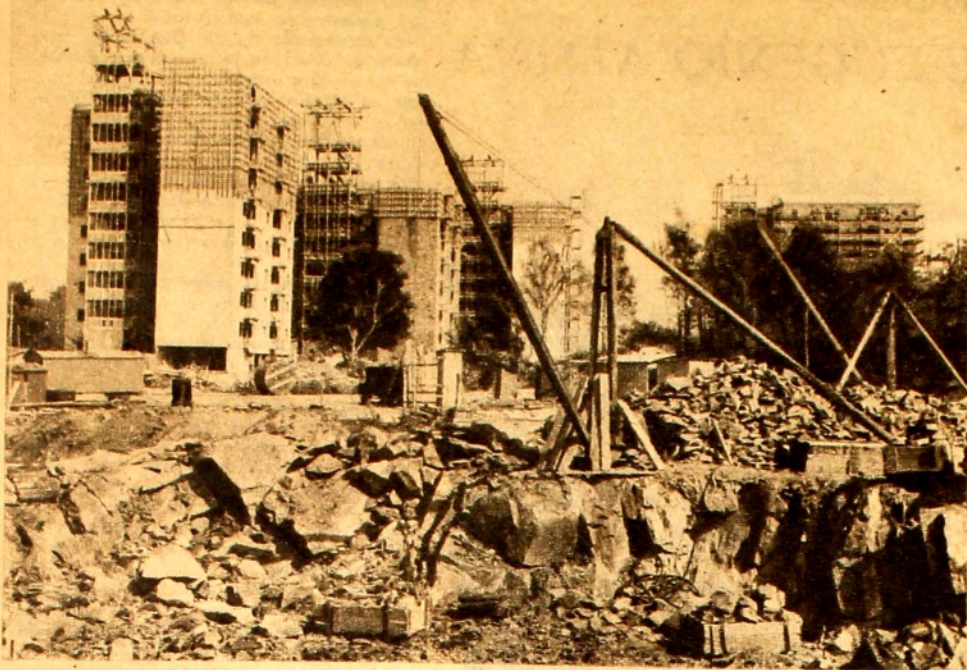
Stockholm. Bloques de vivienda en construcción.
