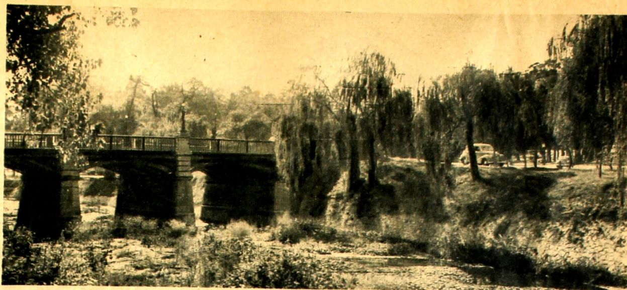
El puente sobre la Avenida Buschental.
