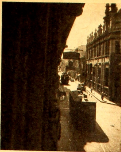
Este edificio en sombras cubre los techos de la viejísima calle del Portón, a la que se alude en la nota. (Hoy 25 de Mayo y Zabala).
