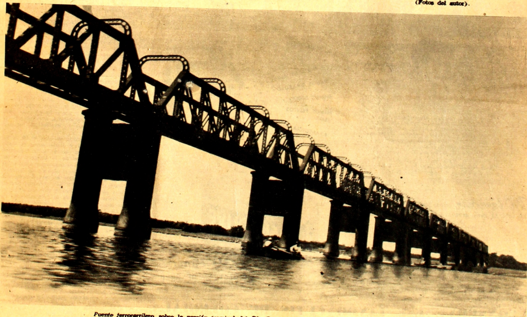
Puente ferroviario sobre la porción terminal del Río Cuareim (entre Puerto Cuareim y Barra de Quarahy).
