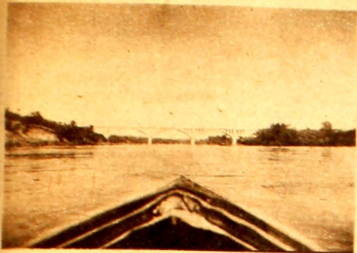
Puente carretero sobre el Río Negro.
