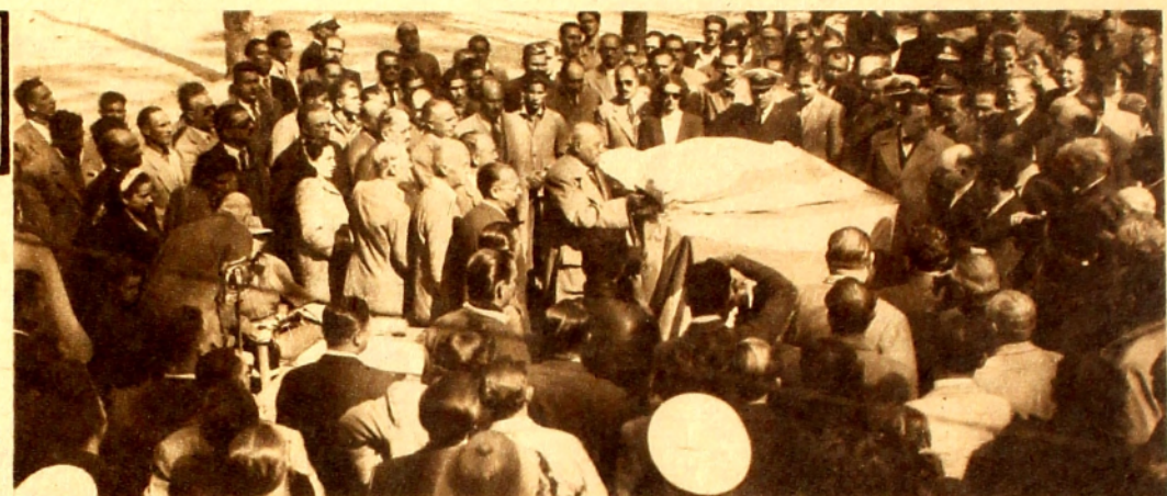
momentos en que el Presidente de la República Don Tomás Berreta descubre la mole de granito que constituye la piedra fundamental de las edificaciones de Punta Ballena.
