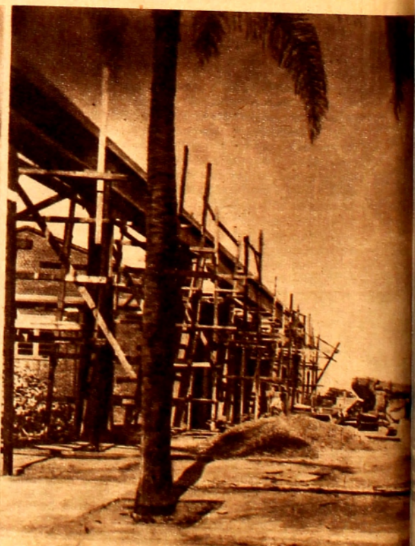
Un aspecto de las obras desde el edificio
