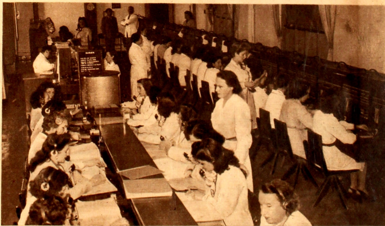
Vista general de la sala de trasmisiones en la central Aguada. A la derecha, las instalaciones para "Larga Distancia". En primer plano, el servicio de informes y el de reclamaciones.
