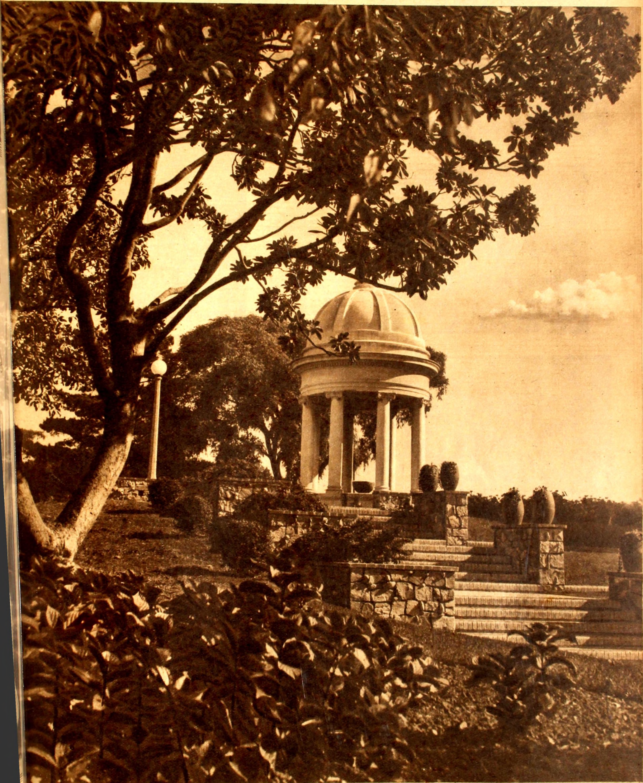
TEMPLETE DEL PARQUE RODO, al que las recientes obras de enjardinado y ornato han embellecido, instalándose una fuente en su centro.
