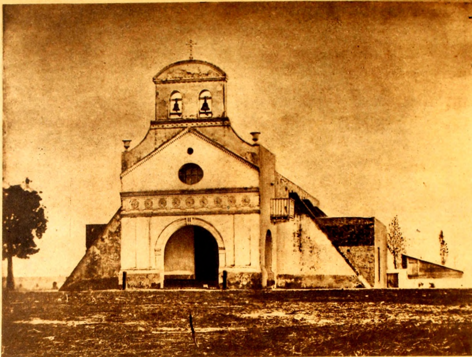
IGLESIA VIEJA EN LA ACTUAL CALLE ZUFRIATEGUY.
