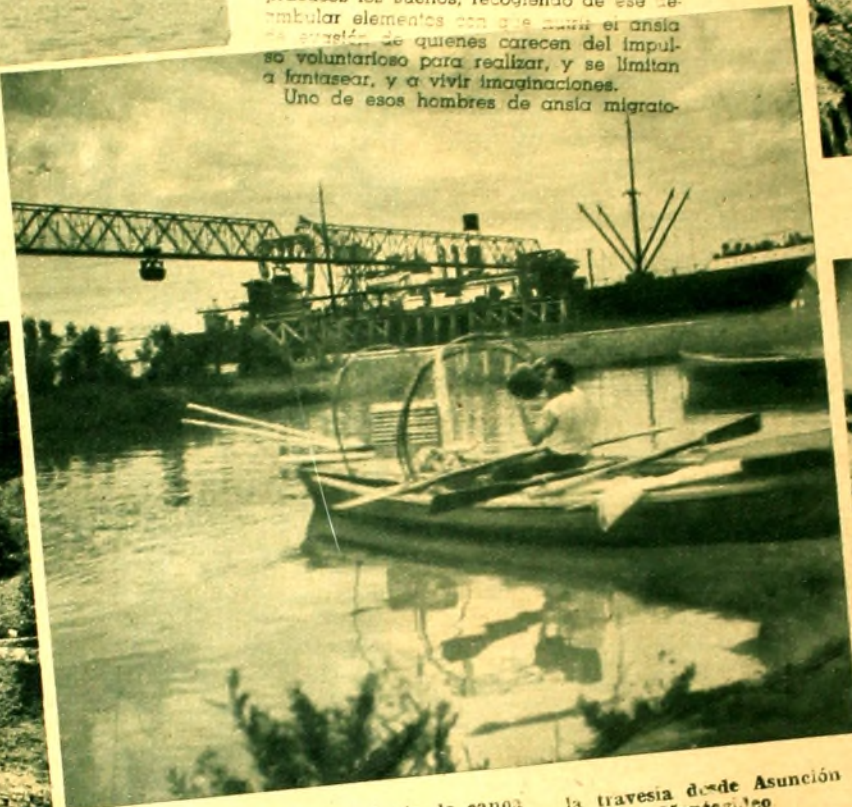
Puente para descargar carbón en la Usina Eléctrica de Rosario (Santa Fe, Argentina).
