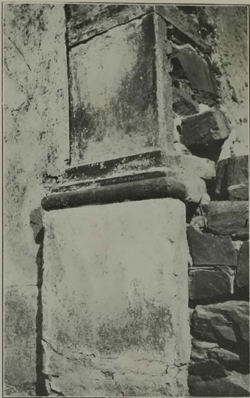
Fig. 88. — Detalle pilastras de piedra de la fachada
