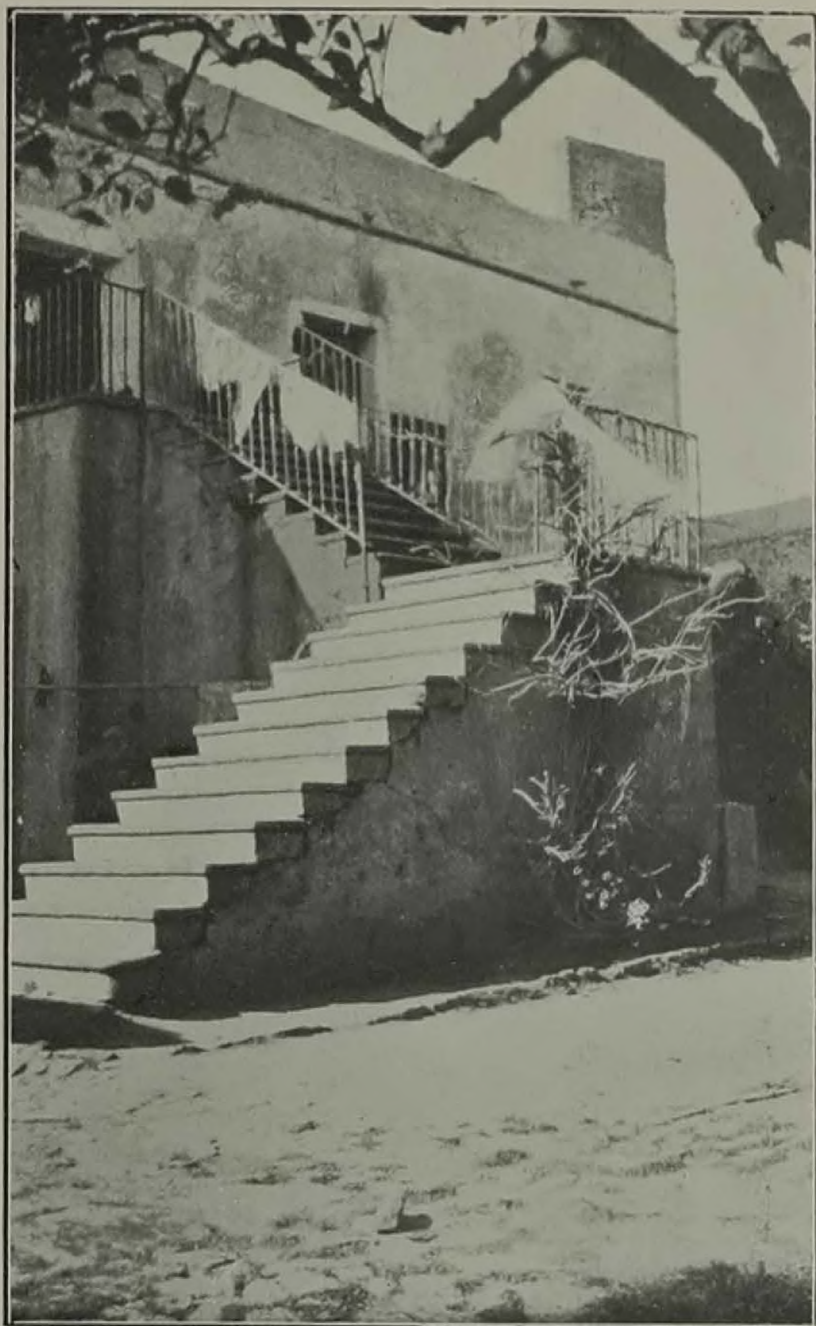
Fig. 87. — Escalera posterior de escalones monolíticos
