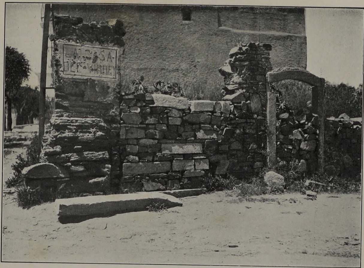
Fig. 69. — Trozo de muro de la casa del Virrey, de piedra grisácea. Obsérvese la entrada formada por jambas y arco escarzano monolíticos. Dimensiones: m. 13 × 18
