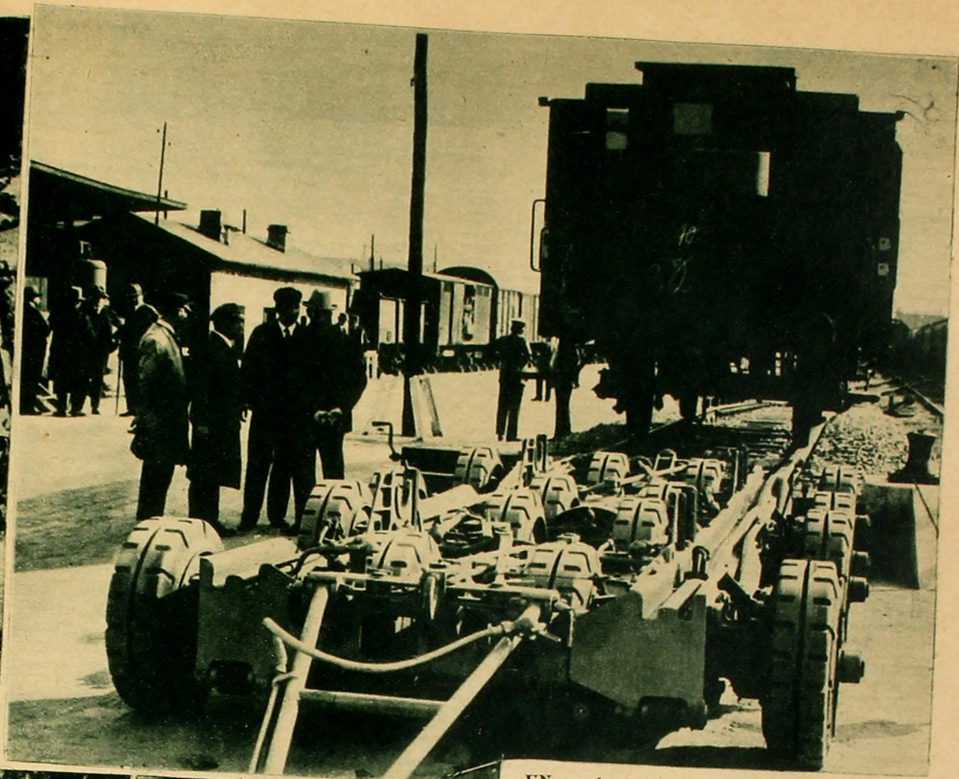
UN empleado de los Ferro-Carriles Culemeyer, de Alemania, ha inventado una especie de zorra sobre la cual se puede deslizar un vagón de ferro carril con toda su carga. Se ahorra de este modo el trabajo de descarga del vagón a otro vehículo de transporte
