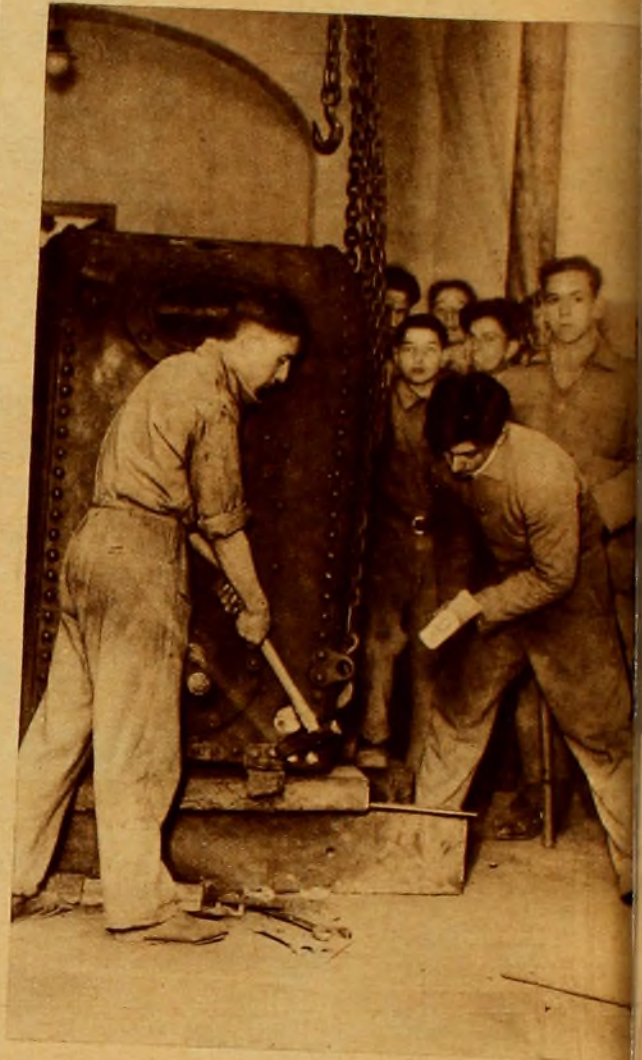
CORTANDO los remaches de una caldera
