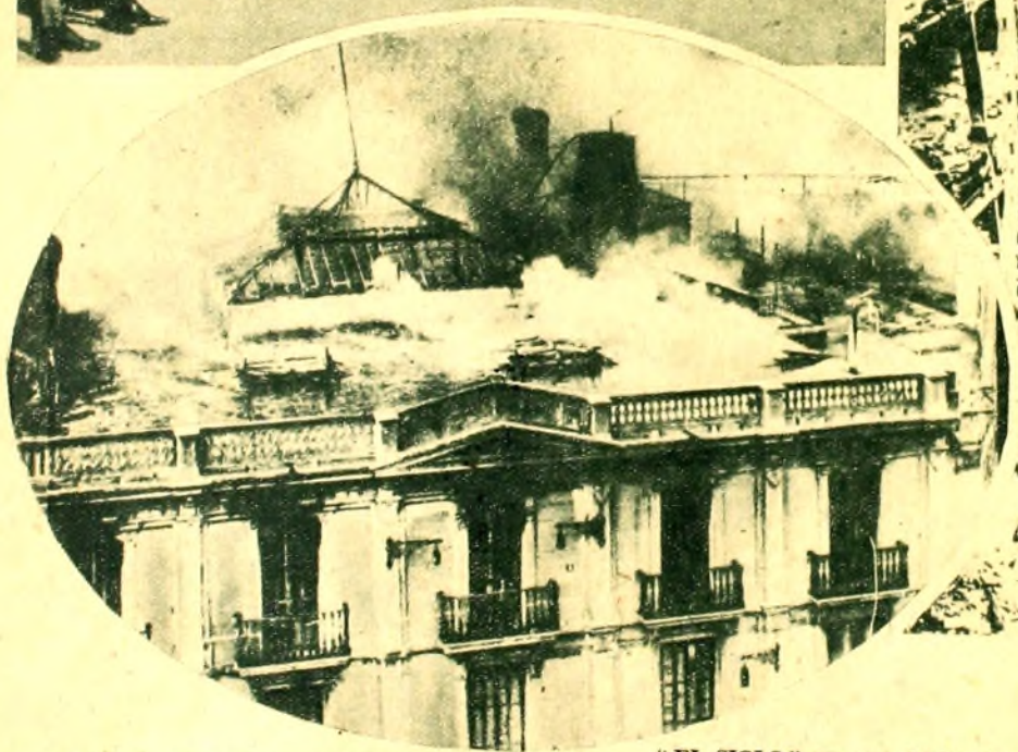
NOTA tomada durante el incendio de los almacenes "El Siglo"
