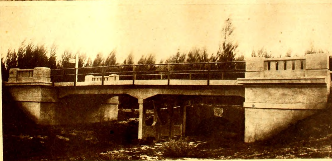
Puente sobre el río Santa Lucía (cauce secundario). (Longitud 40 metros)
