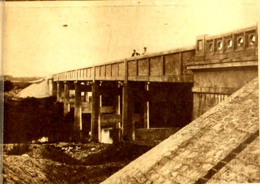
Puente sobre el arroyo Tala (Longitud 90 metros)
