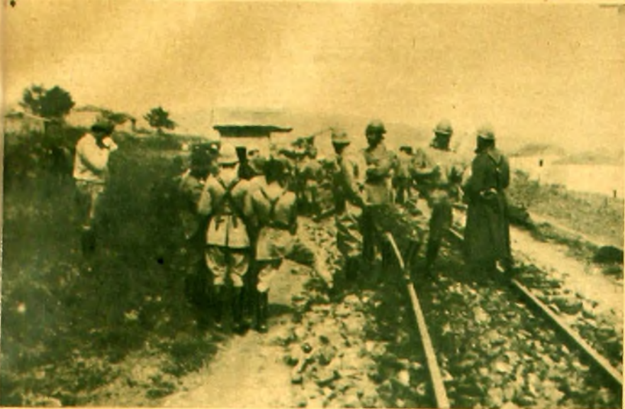
Reconstrucción de la línea férrea, sector sur, por tropas federales brasileñas
