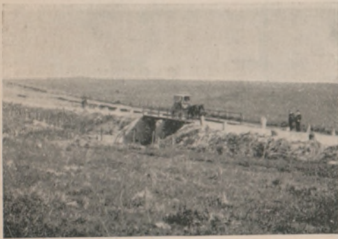
Vista general del puente, terraplenes y afirmado, construido sobre el arroyo «Zanja Honda», camino Guaycurú, de 10 metros de largo con dos tramos de 5 metros cada uno.
