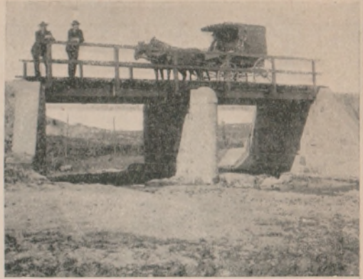
Vista del puente de dos tramos, de cinco metros de luz cada uno, sobre el arroyo «Zanja Honda», camino Guaycurú.
