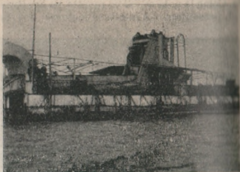
Materiales para el puerto Un detalle de la draga "Sousse"
