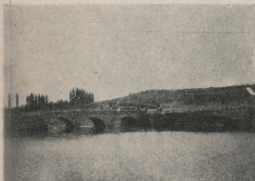
Puente sobre el arroyo Ceibal
