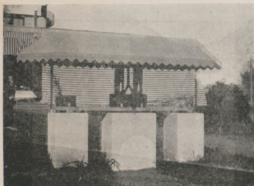
Aparato inventado por el Sr. Morandi para la graduación de la evaporización del agua y de la humedad de la tierra
