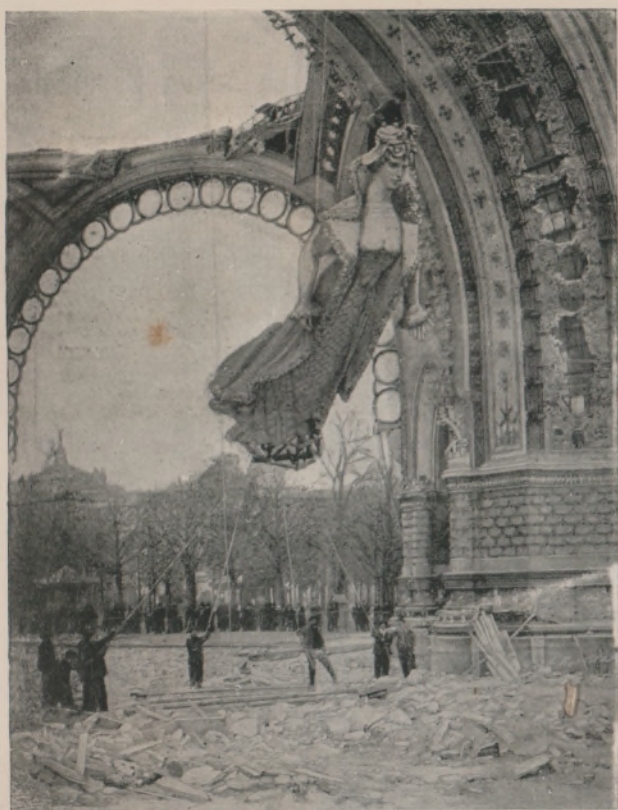
Demolición de la Puerta Monumental de la Exposición de París de 1900.—El descenso de la colosal estatua "La Parisienne" colocada sobre la Puerta Monumental.
