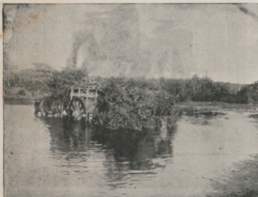
Paso de "Barbachán" antes de construirse la calzada
