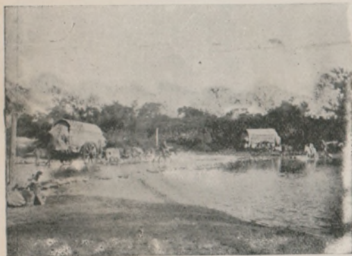
Calzada nueva del paso de "Barbachán"
