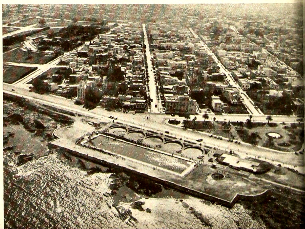
La piscina y parte del balneario Pocitos
