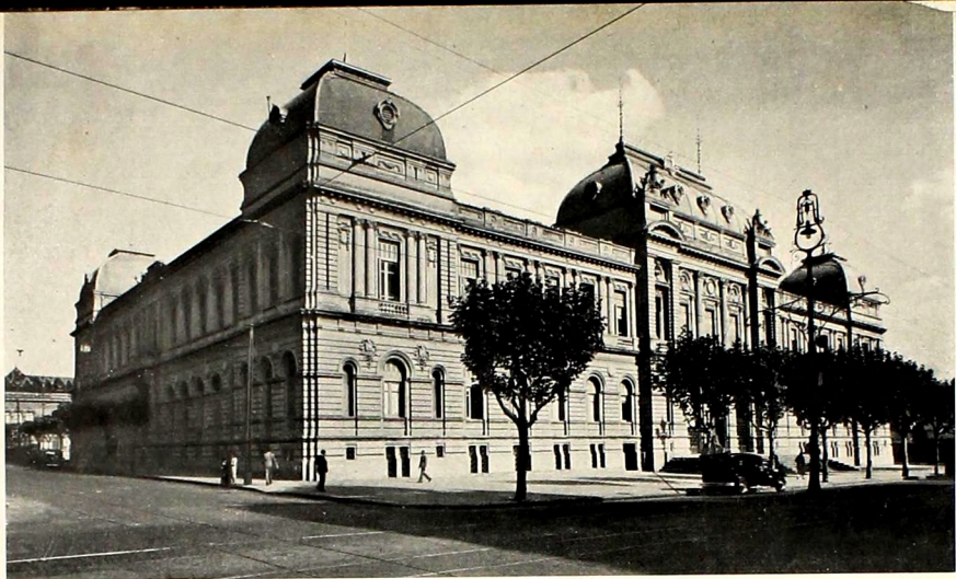
Edificio de la Universidad, una de cuyas alas ocupa la Biblioteca
