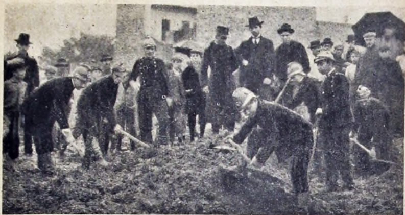
Los bomberos haciendo las excavaciones en el sitio donde fueron enterrados los 500.000 pesos
