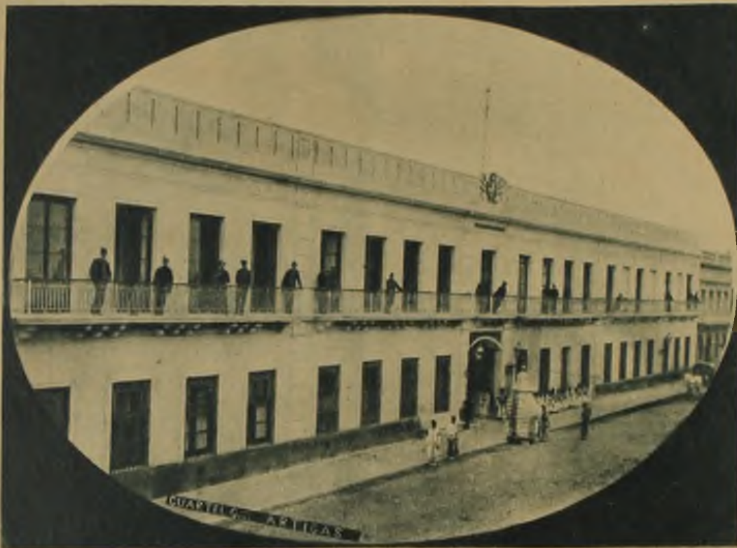
Vista del famoso Cuartel del 5° en la calle Aracriada entre Rondeau y Cuareim, demolido en la actualidad y que oficialmente se llamaba "Cuartel Gral. Artigas".
