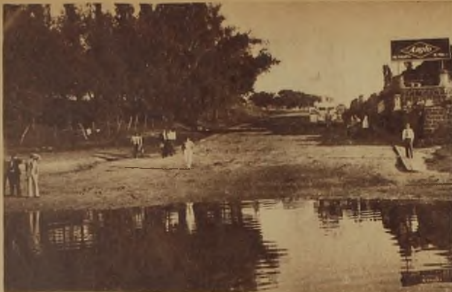
Arriba: Esta es la pendiente que recorrió el ómnibus sin frenos antes de precipitarse en las aguas del Rio Negro. La bajante de las aguas impidió que la tragedia fuera mayor.
