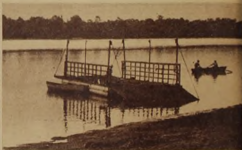
La balsa por encima de la cual, rompiendo las cadenas, se lanzó el ómnibus cayendo a las aguas.
