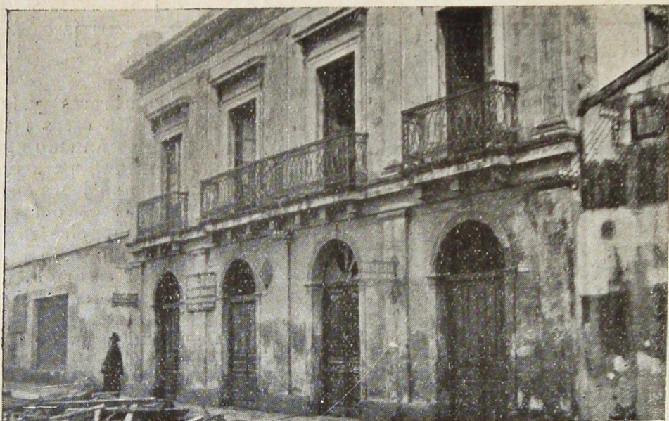
Casa calle 25 de Agosto N.º 320, cuyas piezas interiores se derrumbaron
