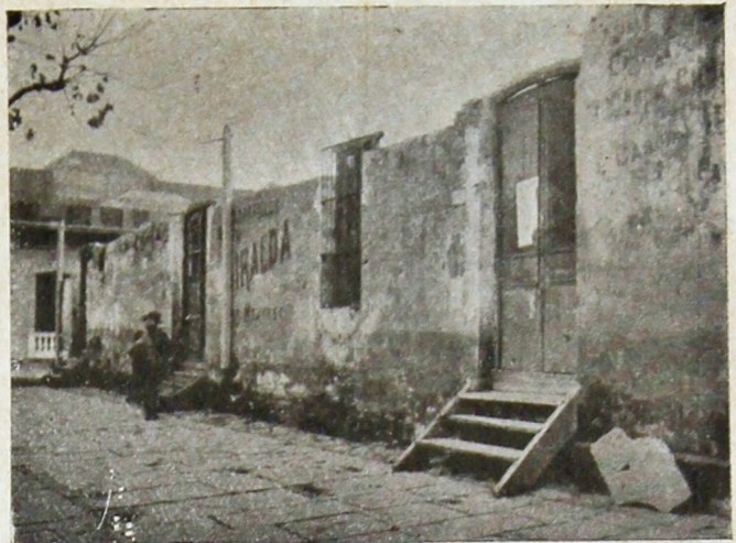
La misma "construcción". Frente sobre Caigua. Calzada obstruida y una rinconada "sospechosa"
