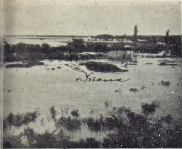
gar donde se construye el edificio para la nueva aduana, inundado
