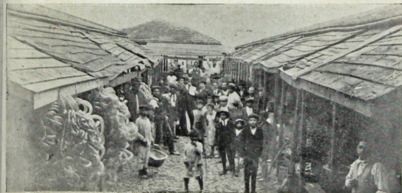
terior del Mercado maragato, que pronto será ensanchado y refaccionado, para llenar las necesidades actuales de la población
