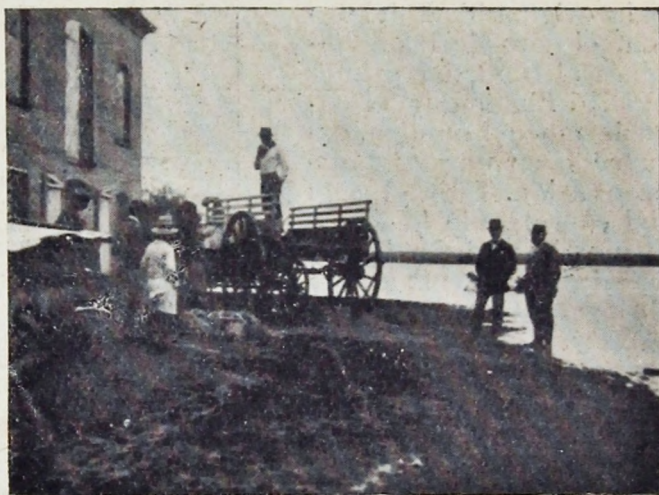
En el Molino San Salvador, preparando mezcla para impedir la entrada de las aguas en el edificio.— Fot. César Ramagli.
