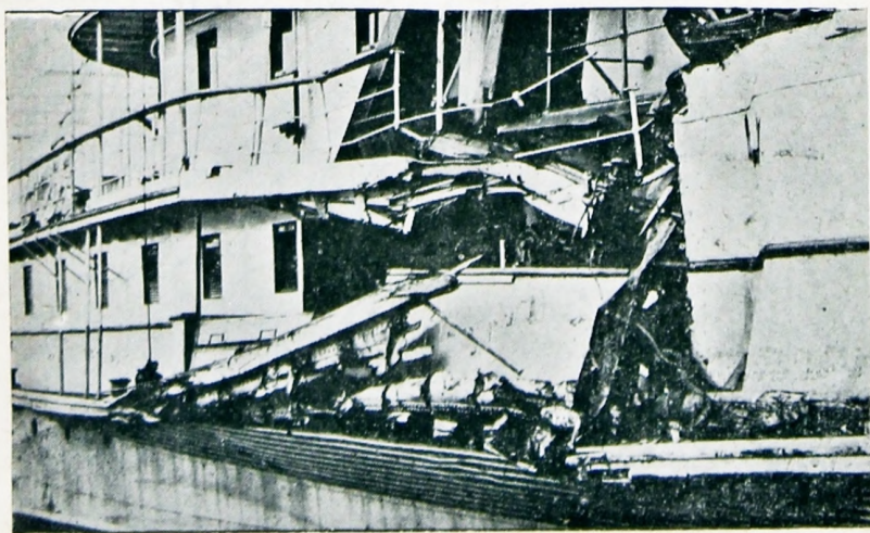
El vapor «Tritón», á su llegada al Salto Fot. Toucón)
