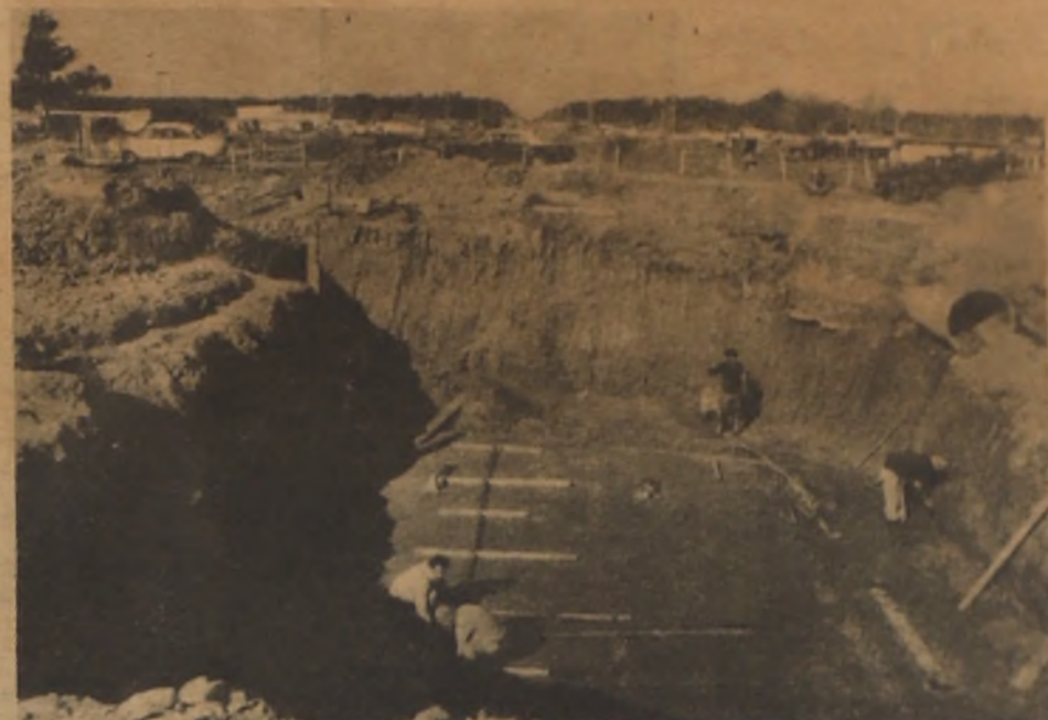
Grandes volúmenes de tierra debieron movilizarse en Maldonado para entubar las aguas pluviales, para eliminar el drama de las inundaciones.
