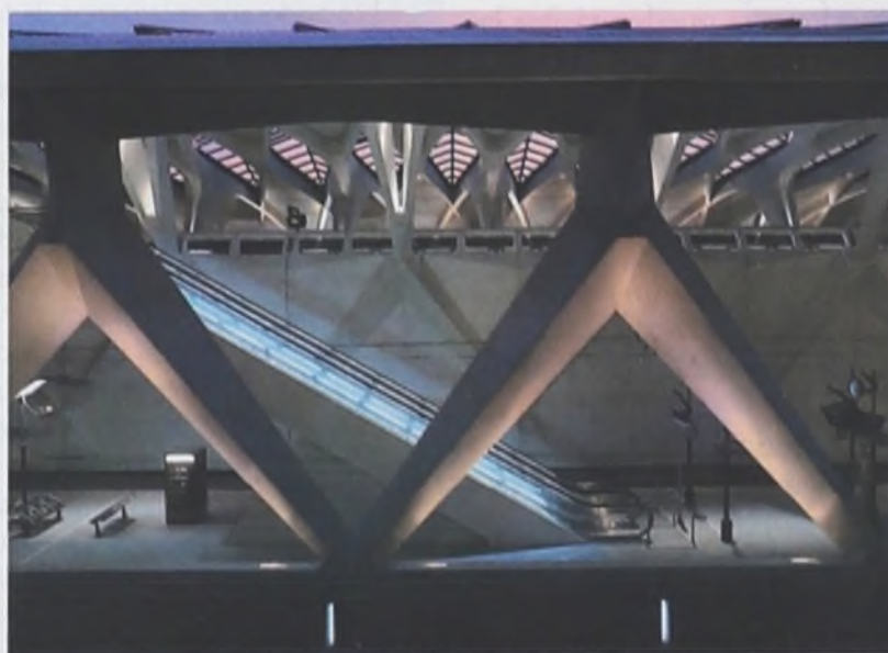
Estación ferroviaria del Aeropuerto de Lyon.
