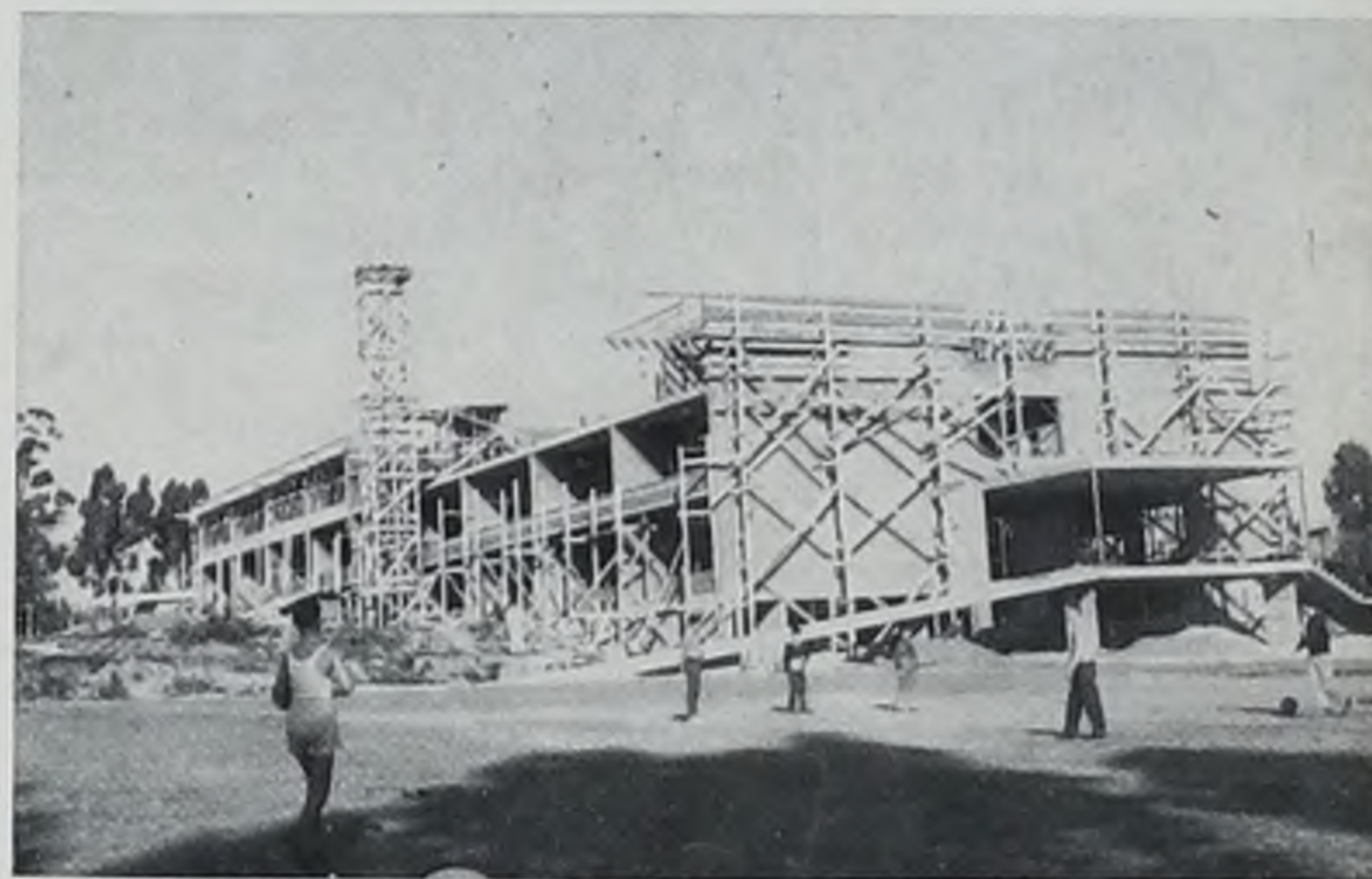
Con ritmo acelerado se inician las obras.
