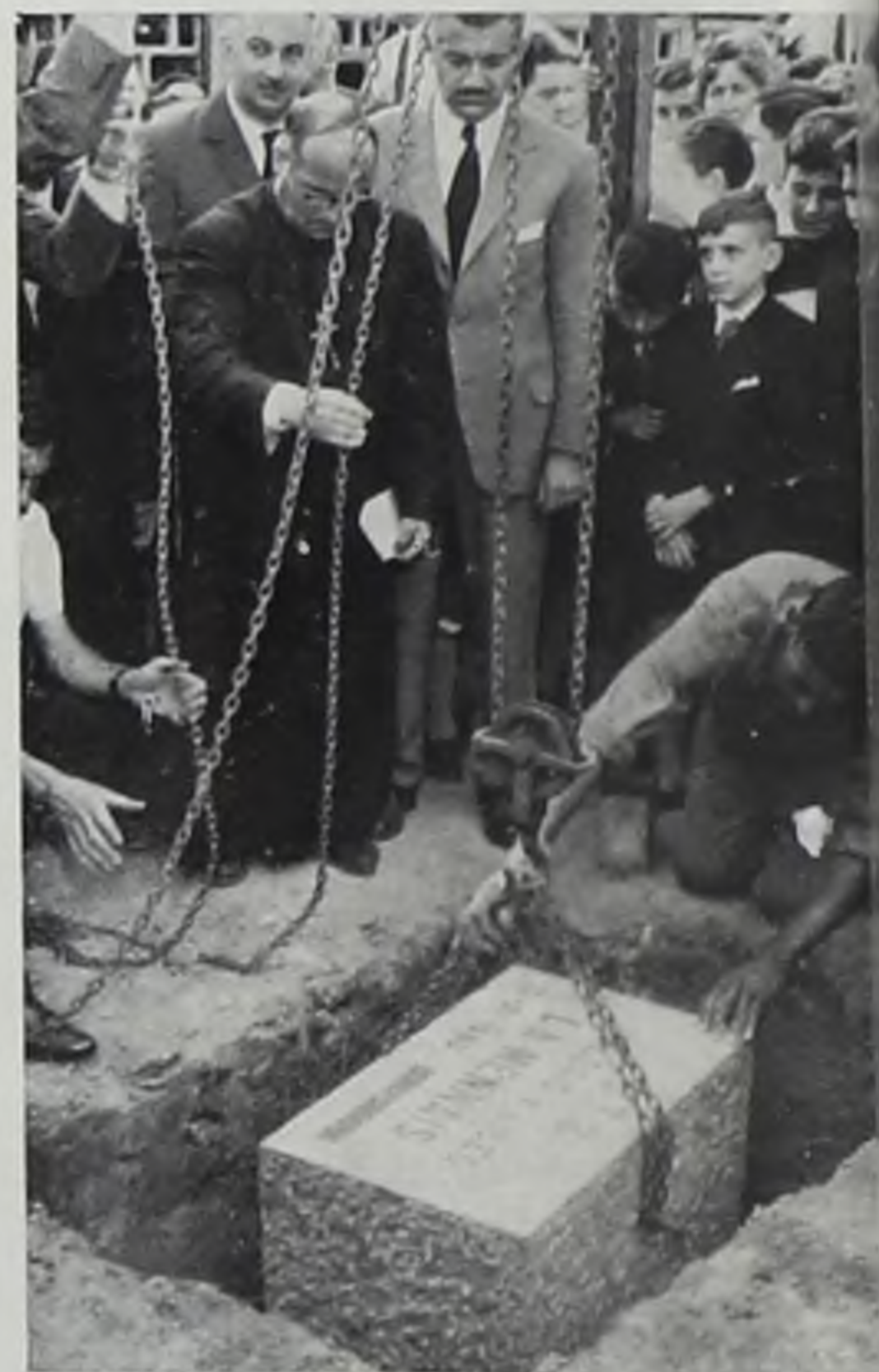
Colocación de la Piedra Fundamental del Colegio
