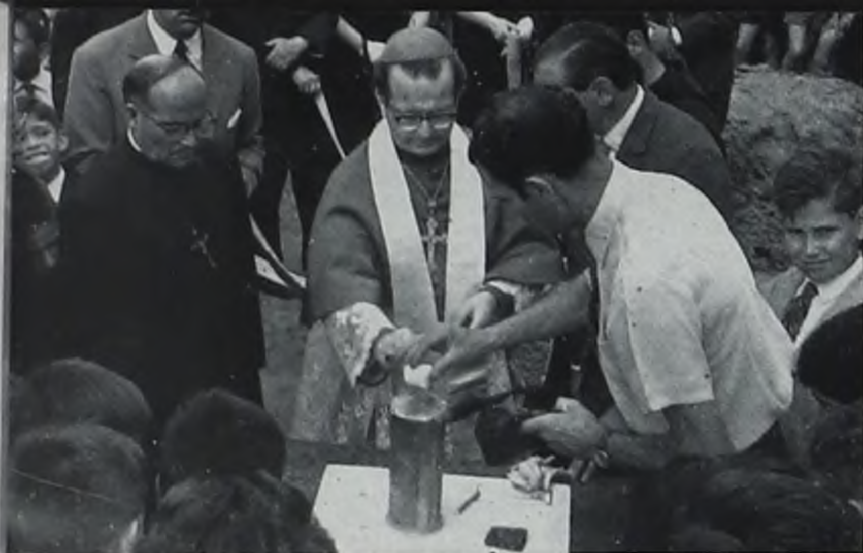
Pergamino, Firmas, Reliquia del V. P. Fundador depositadas en caja de plomo en el interior de la Piedra Fundamental.
