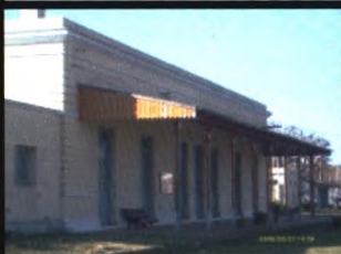
EST. COLONIA, COLONIA Línea Montevideo-Colonia, km 246
