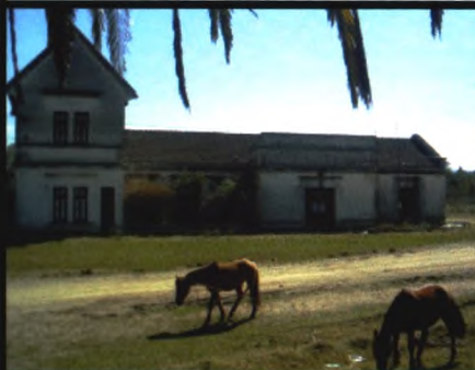
EST. ROCHA, ROCHA Línea Montevideo-La Paloma, km 180
