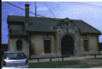
EST. VERGARA, TREINTA Y TRES Línea Montevideo- Río Branco, km 390
