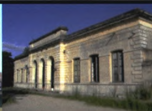
EST. ROSARIO, COLONIA Línea Montevideo-Colonia, km 180
