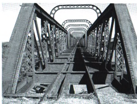
Puente internacional sobre el río Cuareim, Artigas
