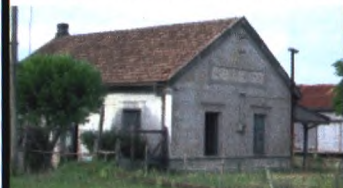
EST. ARROYO GRANDE, SAN JOSÉ Línea Montevideo-F. Bentos, km 160
