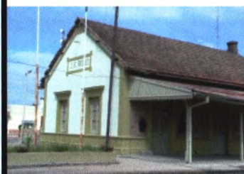
EST. RODÓ, SORIANO Línea Montevideo-F. Bentos, km 219
