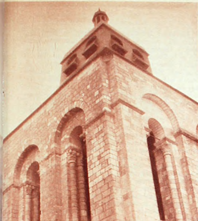
Detalle de la torre sobre el porche de entrada
